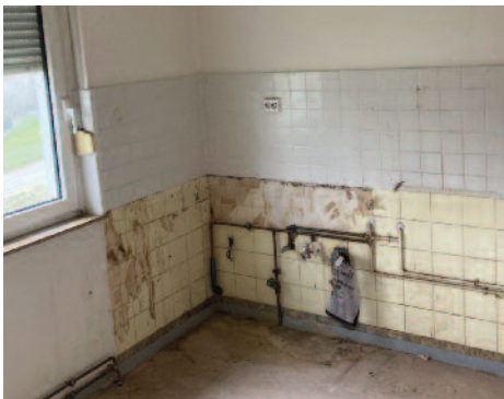
So sieht's noch aus: Die zukünftigen Duschen.
